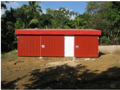
Ilustración 4. Horno Solar para el Secado de Madera.
